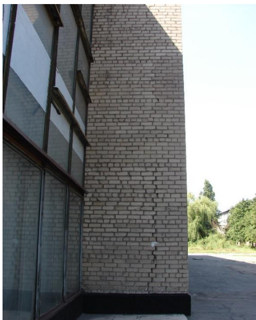
Рис. 12. - Тріщина шириною розкриття до 1 см в нижній частині правої поперечної стіни біля центрального вітража
